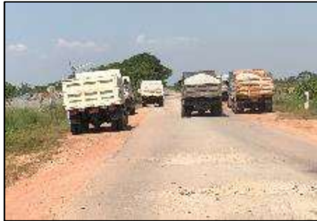
大型車交通量の多い地域で 舗装の劣化が発生
