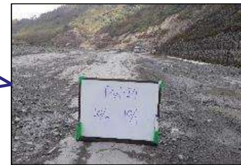
標高が高く、気温の低い 地域で舗装の劣化が発生
